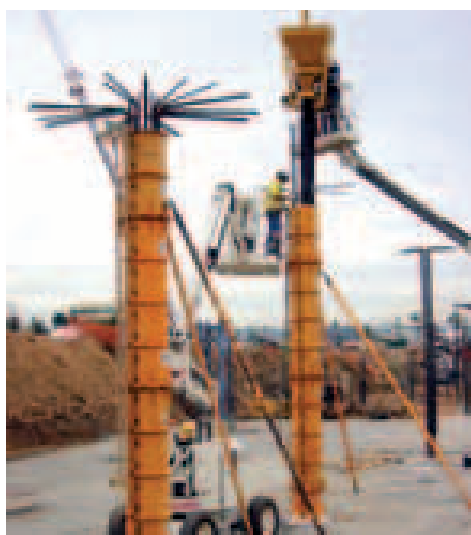
Fase de hormigonado
