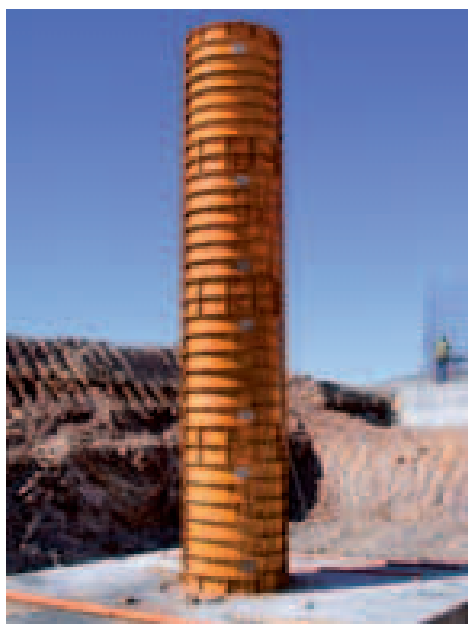
Pilar Ø 120 cm en ejecución de puente
